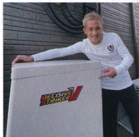
蓄電池設置写真 協力:関口訓充選手
